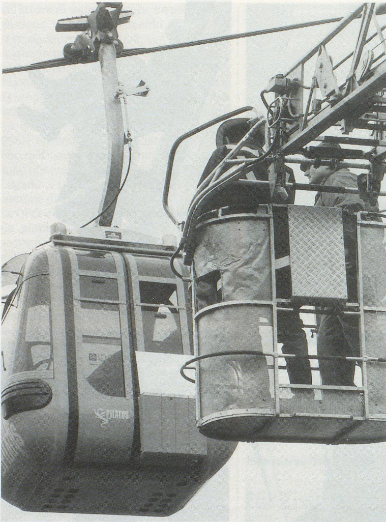
Ein Fall für die Feuerwehr: Bergung aus der Seilbahnkabine mittels Auszugleiter und Rettungskorb.
