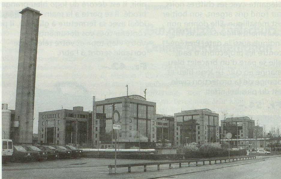
Les bâtiments des Services industriels genevois (SIG).
