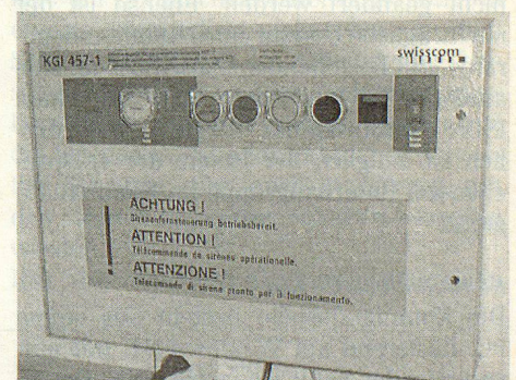
Bild 2: Kommandogerät mit Tasten und Schalter für zehn Alarmierungsbereiche.
