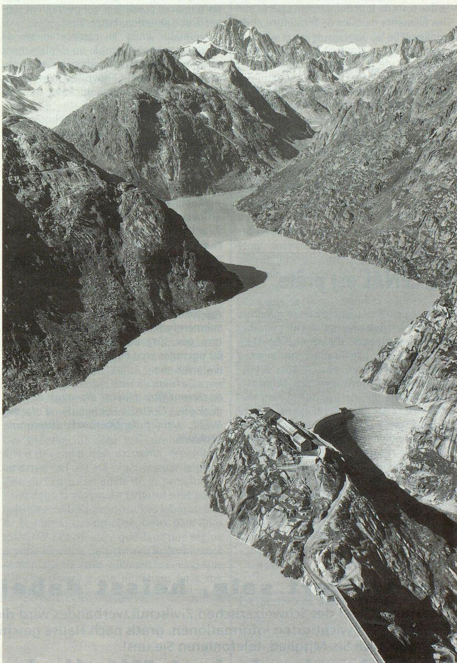
Le lac du Grimsel, d'une capacité de 100 000 mètres cubes; à droite, la «Spitallammsperre», un barrage en voûte de 114 m de haut et 248 m de long.
