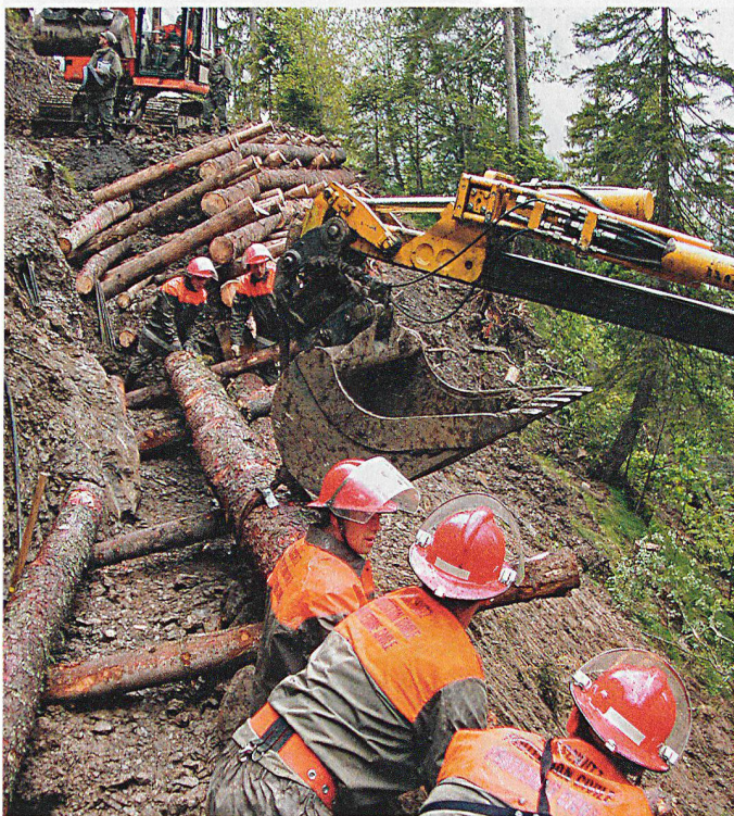
Kastenbau in unwegsamem Gelände.
