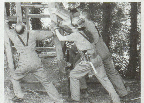
Beim Rückbau der Kläranlage.
