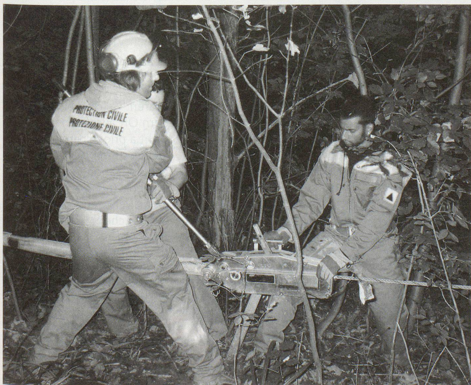
Unwetterschäden werden behoben.
