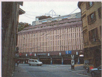
Stahlbeton Parkhaus (ganz kleine Öffnungen)
