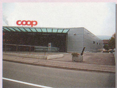
Supermarkt (Stahlbeton, Metall, ohne Öffnung)
