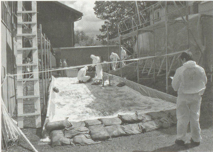
Einrichten einer Schleuse und Dekontaminationsstelle für Menschen und Fahrzeuge.
