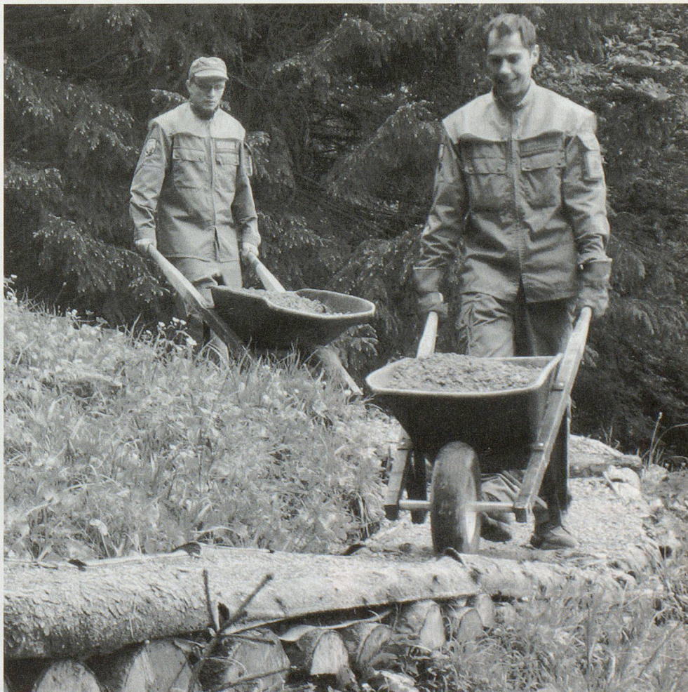
Sanierungsarbeiten beim Urnäsch Chräzerli.
