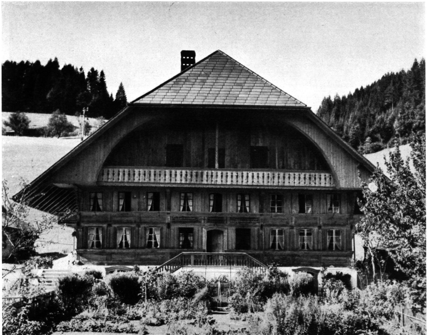
Das Haus, wie es heute steht. Den Umbau besorgte in vorbildlicher Art und Weise Zimmermeister Lanz, Längmatt bei Zollbrück. Man beachte die feingeschwungene Linie der Ründe sowie die einfachen, materialgerechten Laubenausschnitte.
