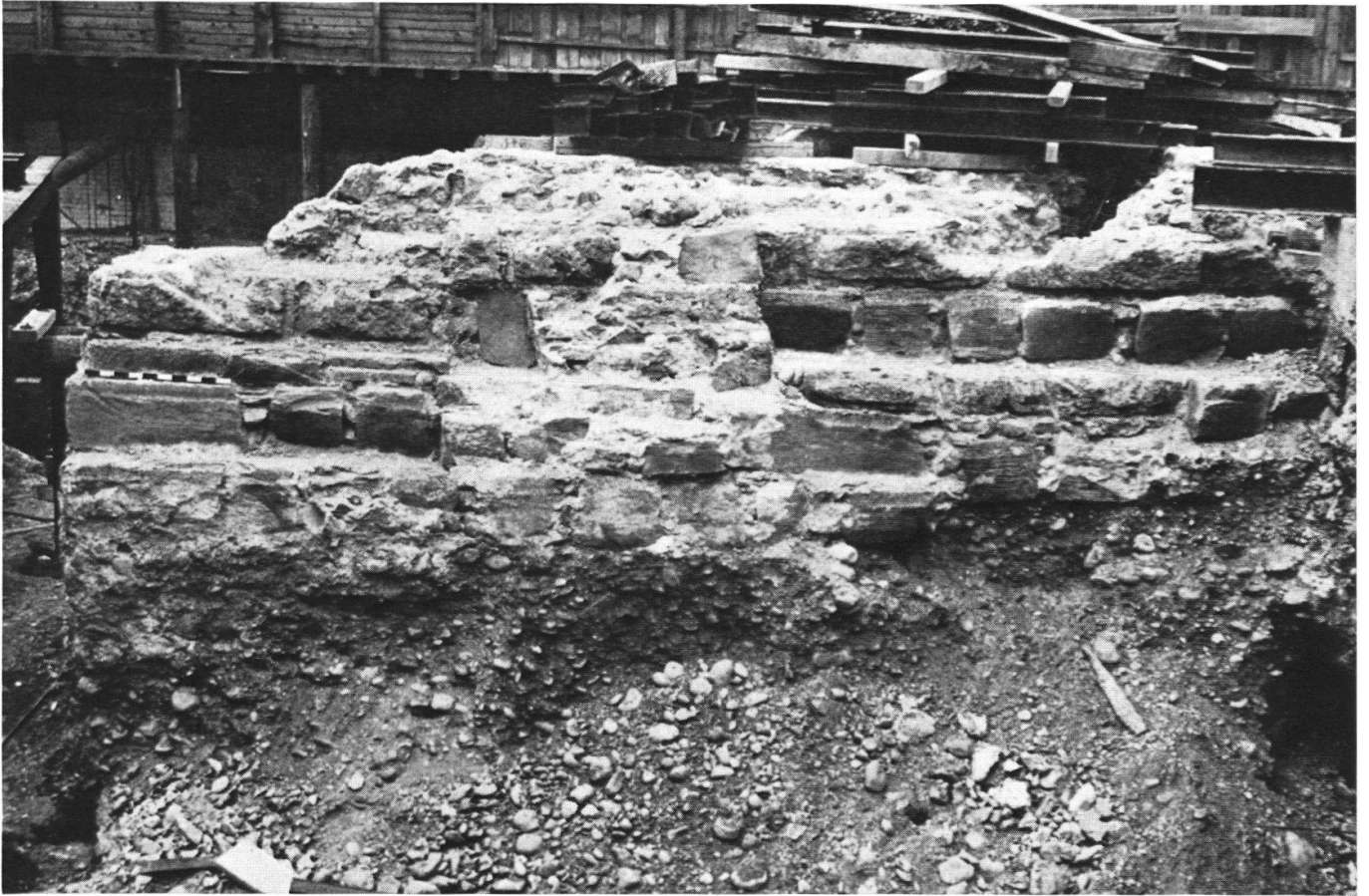
Abb. 5: Fundament der Südfront des Christoffelturms, nach Wegnahme der inneren Stadtmauer.
