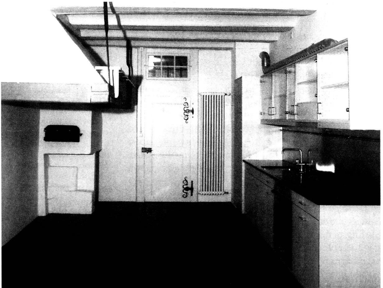
vorzuheben ist der jahrzehntelang als Veloabstellraum genutzte Erdgeschossraum zur Gasse, der als Wohnküche in die neue Erdgeschosswohnung integriert wurde. Der Raum zeigt noch die spätgotische Konstruktion des Vorgängerbaus mit einer auf Konsolen und Streifbalken ruhenden Balkendecke, die gereinigt wurde.<sup>205</sup> Der fehlende Wandputz wurde ergänzt, die nur noch rudimentär vorhandene grau-schwarze Einfassung konserviert.<sup>206</sup>
