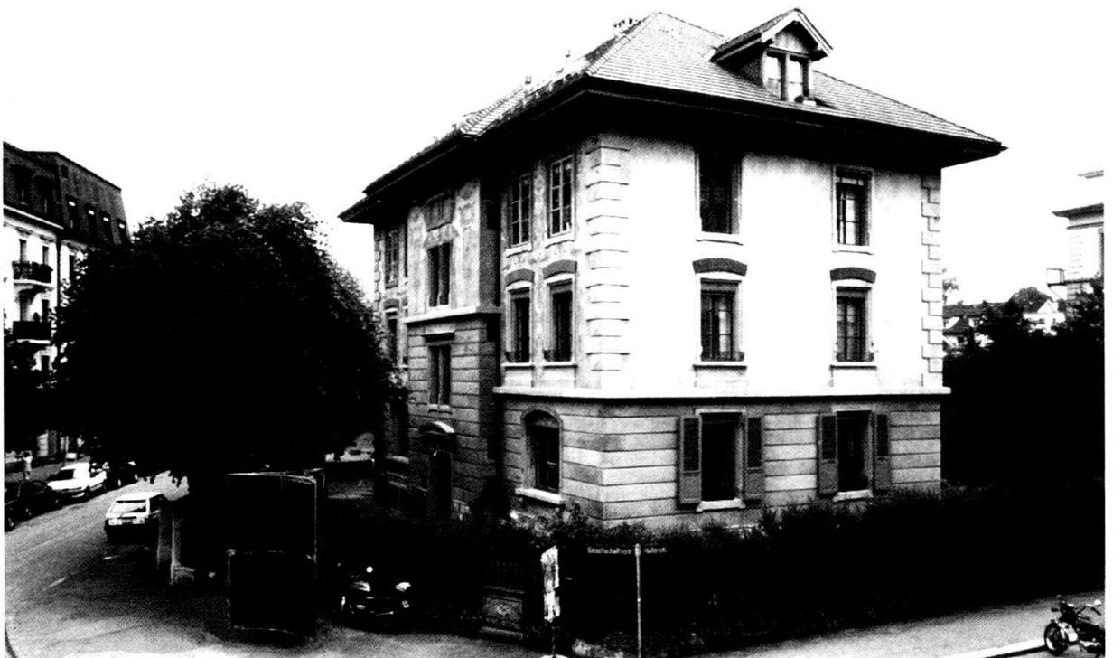
Dabei ergänzte man die bestehenden Giebellukarnen mit minimal dimensionierten Dachflächenfenstern. Die flächige Erscheinung des zu ersetzenden Dachbelags wurde mit der Verwendung eines Falzbiberziegels wiederhergestellt.
