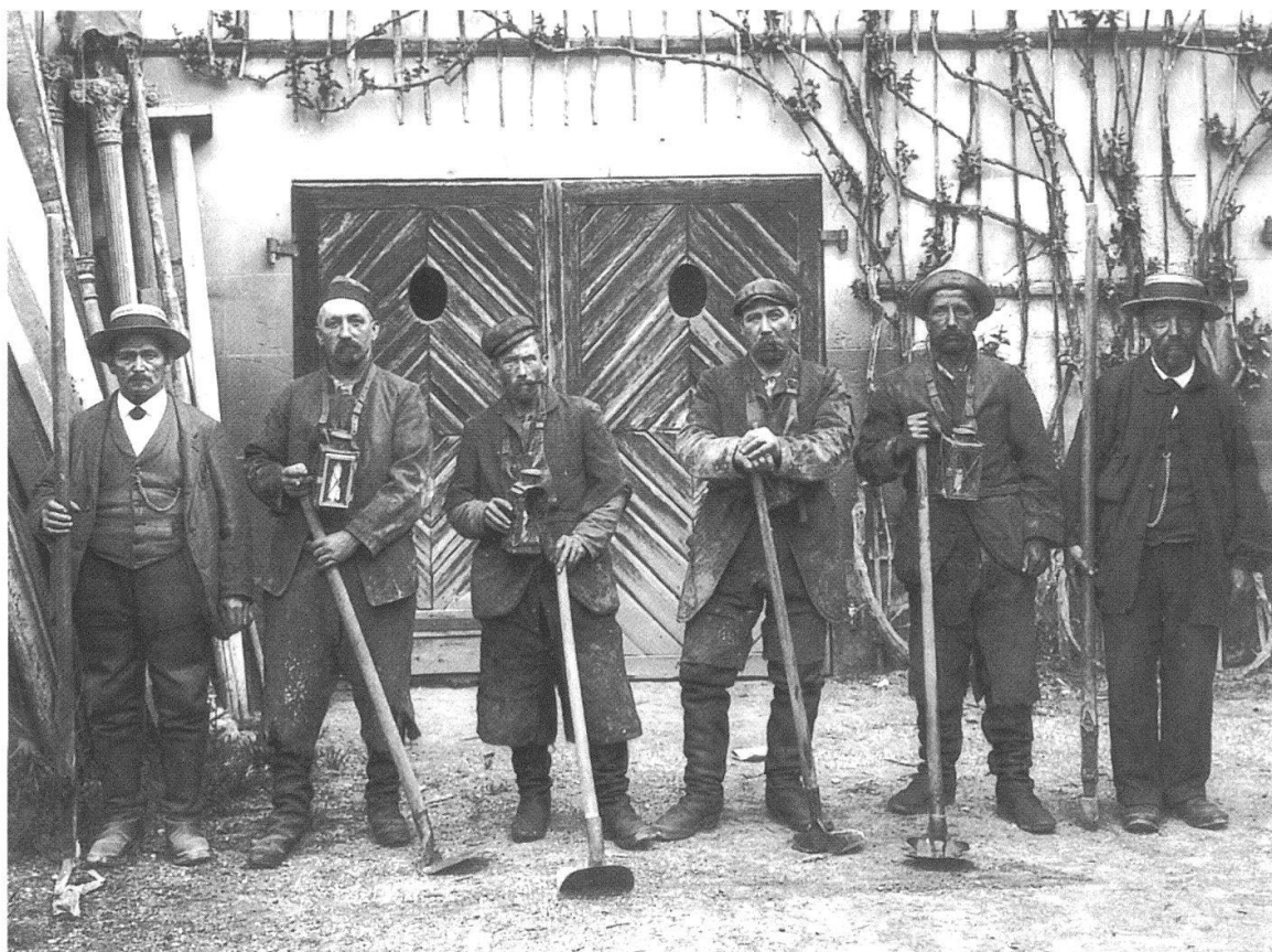
Abb. 7 Für den Unterhalt und die Reinigung der Kanalisation war die Gemeinde verantwortlich. 1876 beschäftigte die Baudirektion fünf Mann, 1912 umfasste der «Kloakendienst» sieben Angestellte. Abgebildet ist die «Kloakenmannschaft» – so der Titel der Foto – um 1910 mit Arbeitsgeräten zur Säuberung der Kanäle, Lampen und hochschaf-tigen Stiefeln, die auf die Arbeit in den nassen, dunklen Kanälen hinweisen.
