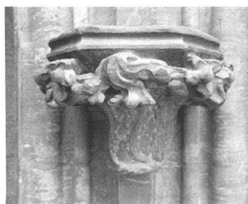
Münster: Nordportal West, Laub- werkkonsole, Zustand vor und nach der Konser- vierung/Restaurierung.
