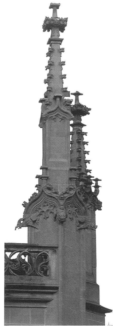
Münster: Westwerk Eckfiale Süd, Schlusszustand nach Kon- servierung/Restaurierung.
