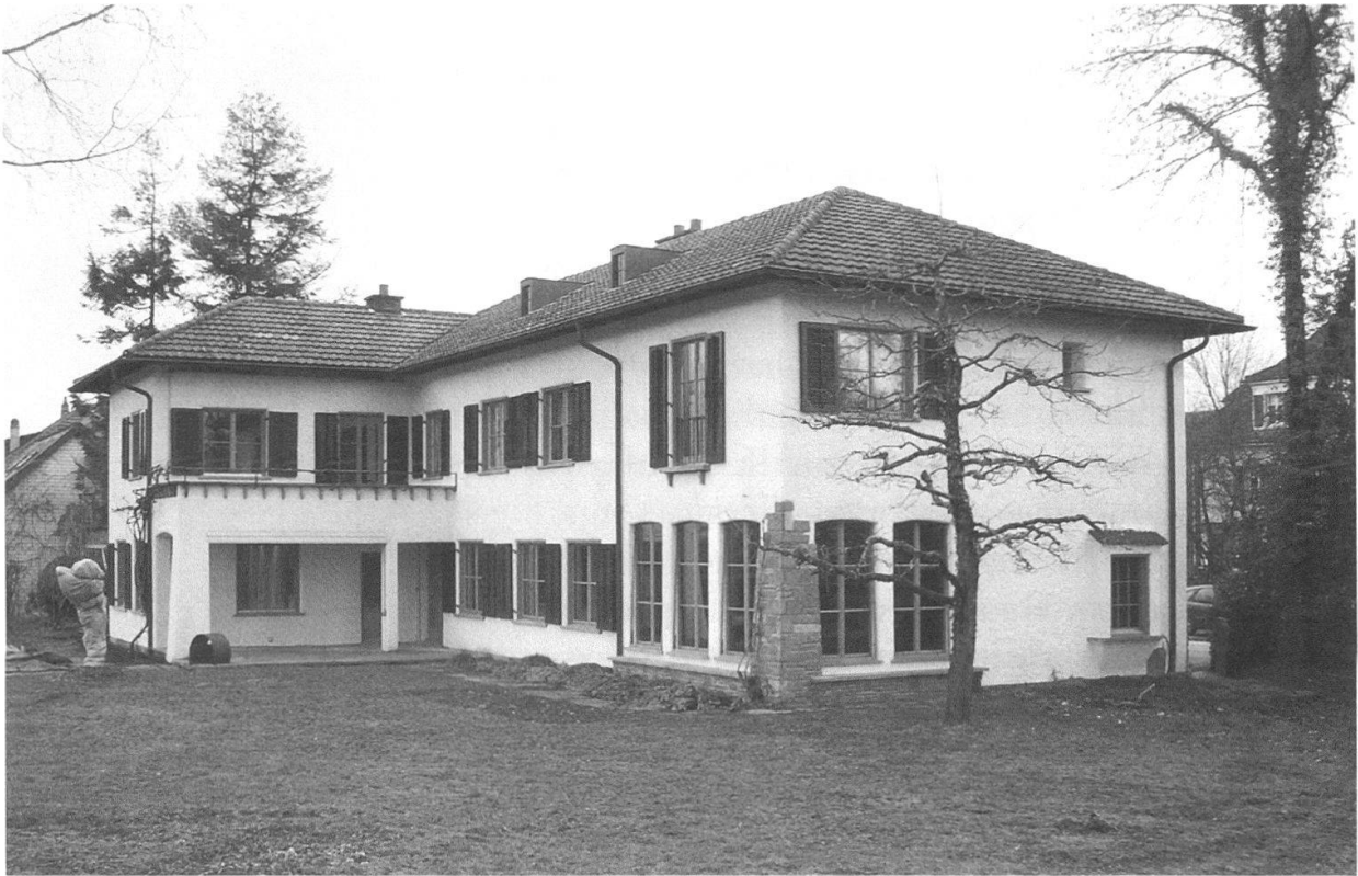
Brunnadernstrasse 95: Ansicht von Südwesten.
