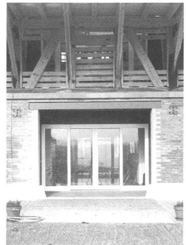
Riedernstrasse 40, 40 A: Neue Fassadengestaltung im ehemaligen Stallteil.
