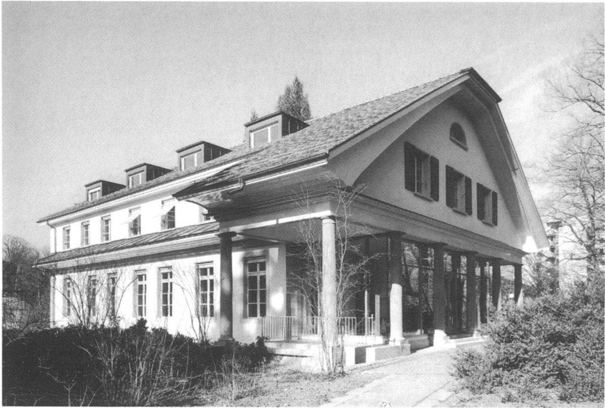
Bellevue Zieglerspital, Morillonstrasse 87: Gesamtansicht Nord- ost mit Peristylanbau Ende 18. Jahrhundert, Aufstockung 1935 und Lukarnenaufbauten 2003.
