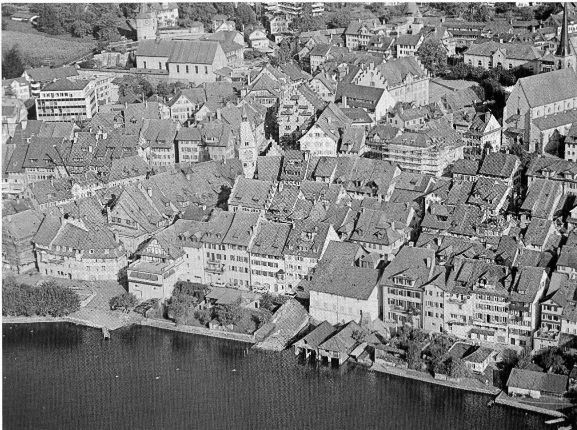
Abb. 1 Dach- landschaft der Altstadt von Zug
