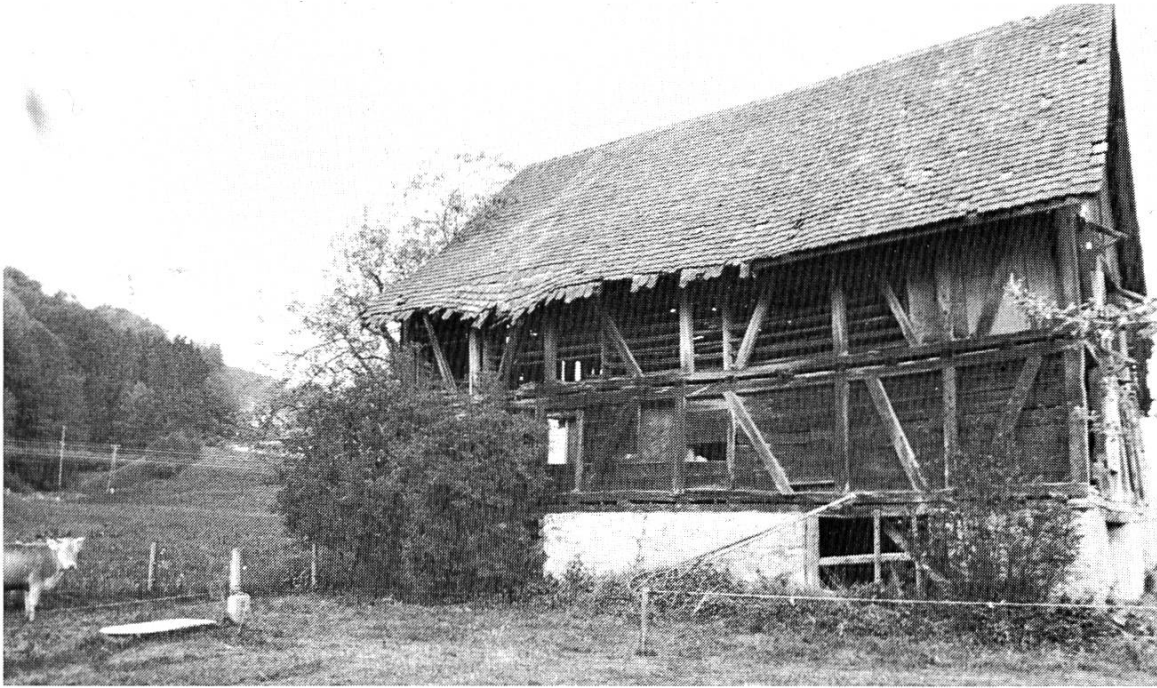
Abb. 21 Rechts die Ostfassade der Ziegelhütte, direkt dahinter das ehemalige Lehmabbaugebiet. Aufnahme 1987
