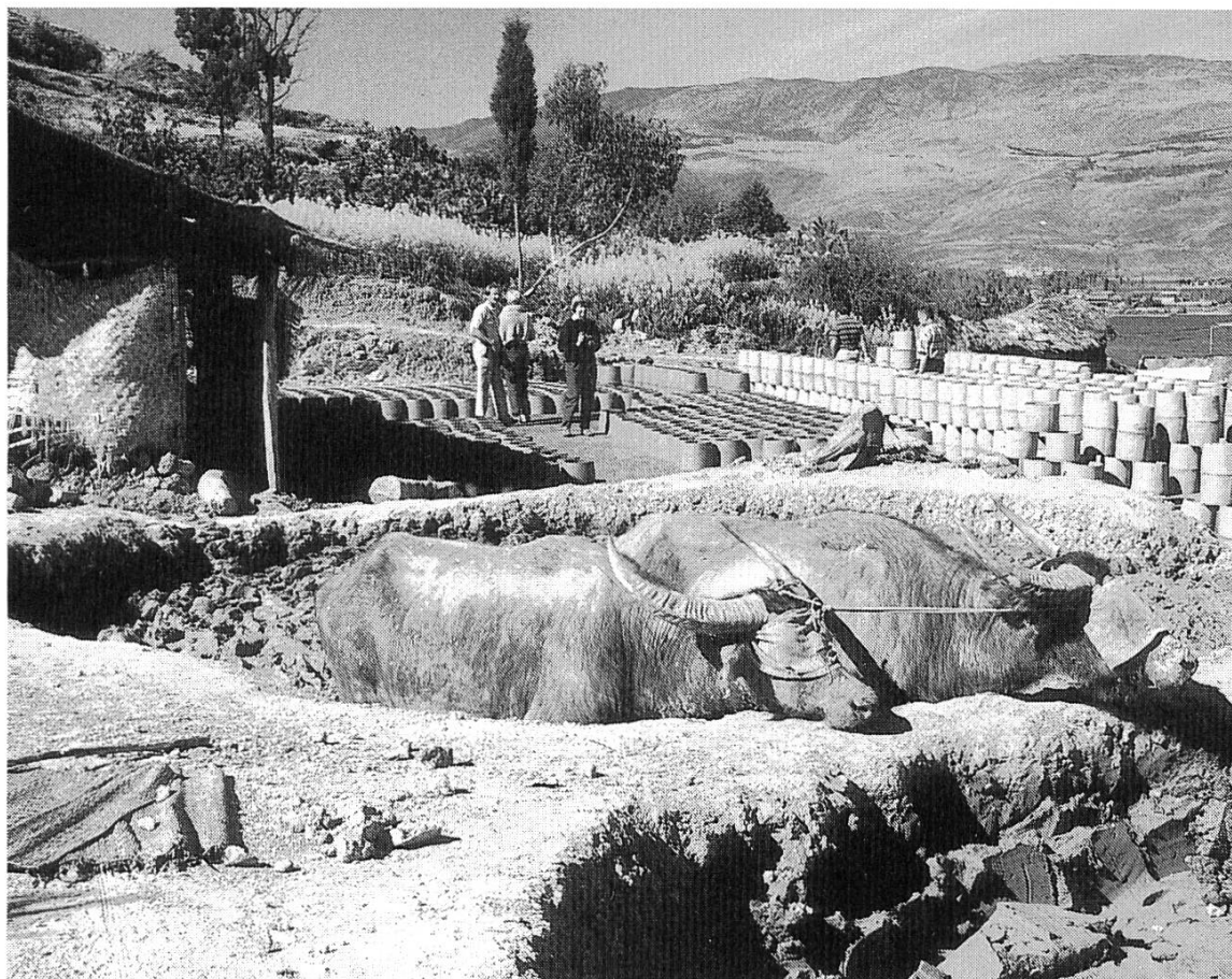
Abb. 1 Wasserbüffel treten den Lehm, bis er weich genug ist für die Ziegel- herstellung
