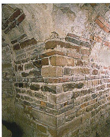
Abb. 2 Basilika Michelstadt. Backsteine im Mauerwerk der Krypta.
