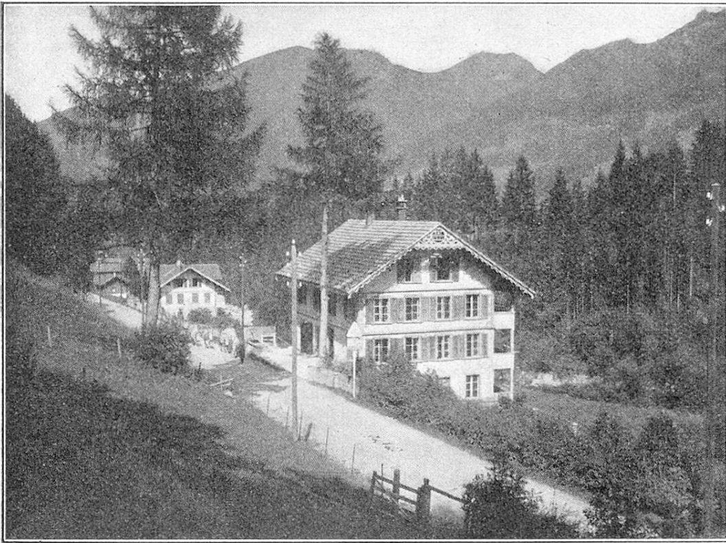
Altersheim Zweisimmen. — Asile de vieillards Zweisimmen.
