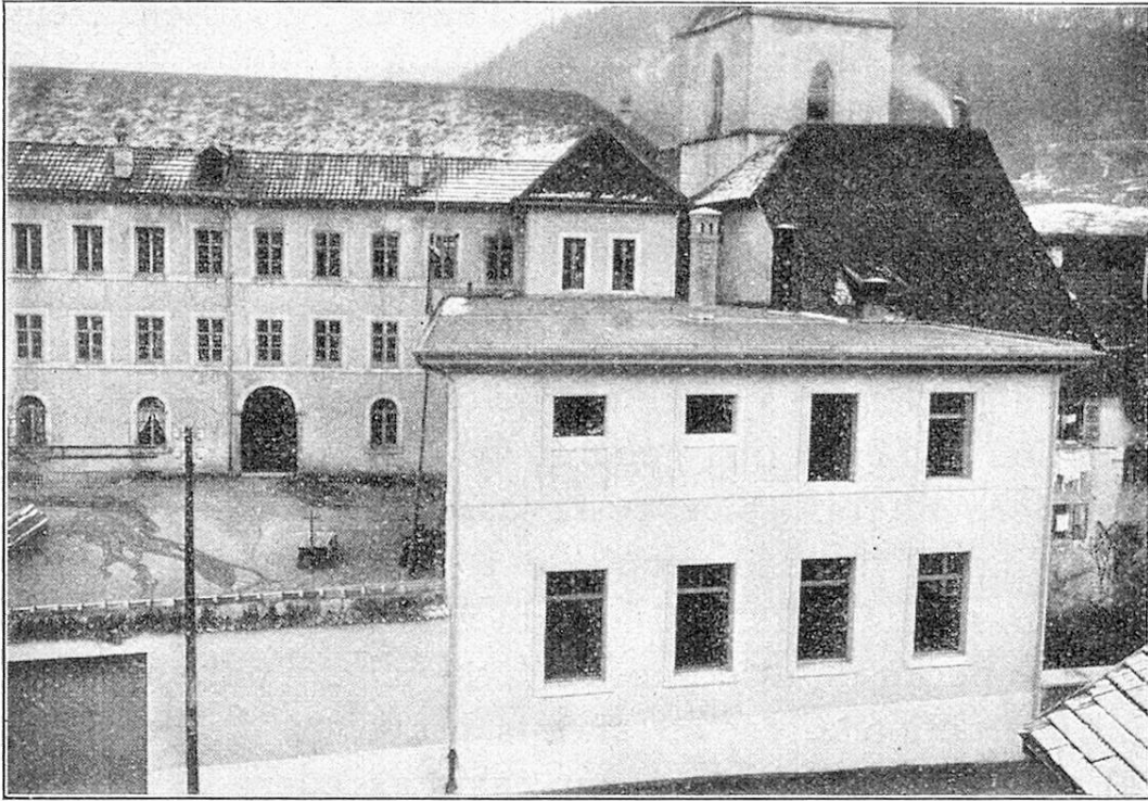
Atelier en construction. — Im Rohbau fertige Werkstatt.
