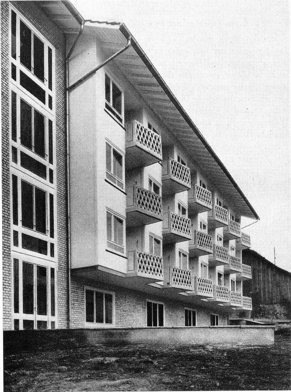
Der Baublock im Gsteig mit seinen hübschen Balkonen
