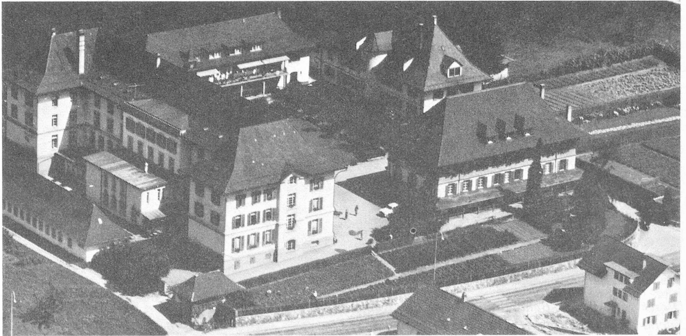
Die alte Bärau, deren Gebäude weitgehend den Neubauten weichen mussten.
