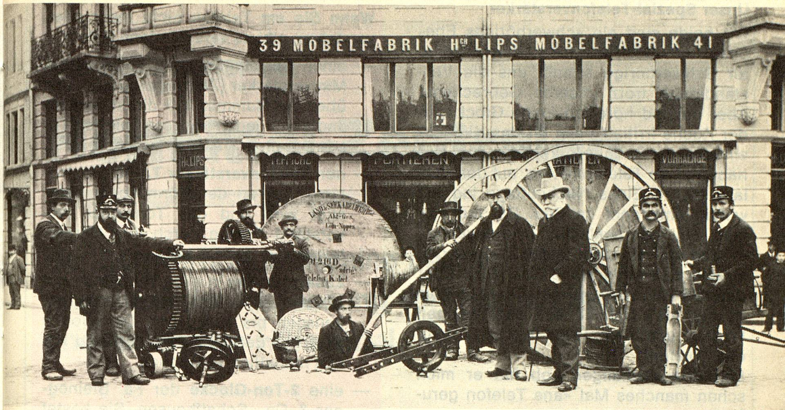
So wurden 1894 in Zürich die Kabel verlegt.
