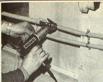
Löten einer Kupferrohr-Warmwasserleitung ohne Brandgefahr für Holz, Kabel und Kunststoffleitungen
