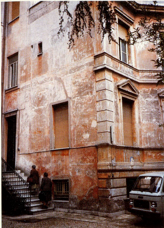
Das Haus hat schon bessere Tage gesehen.
