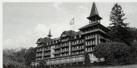
Renoviert/Zimmer mit Dusche/WC/Balkon/Selbstwahl-Telefon/Lift
