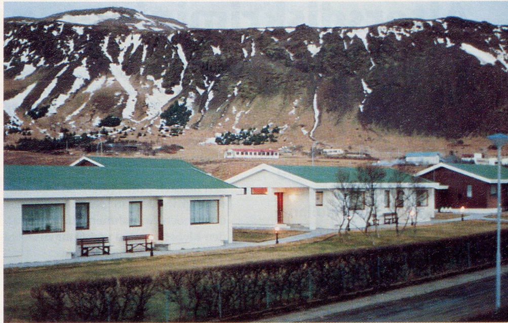
Ein Teil der Alterssiedlung in Hveragerði.
