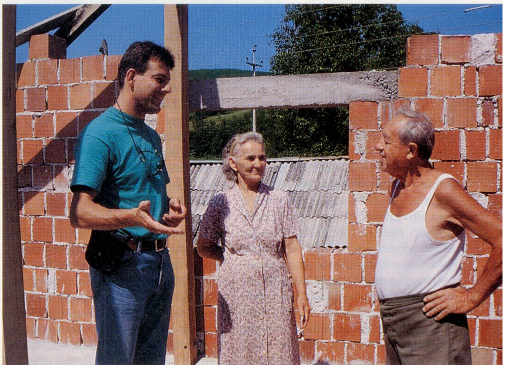
Viele ältere Menschen müssen beim Häuserbau noch Hand anlegen.
