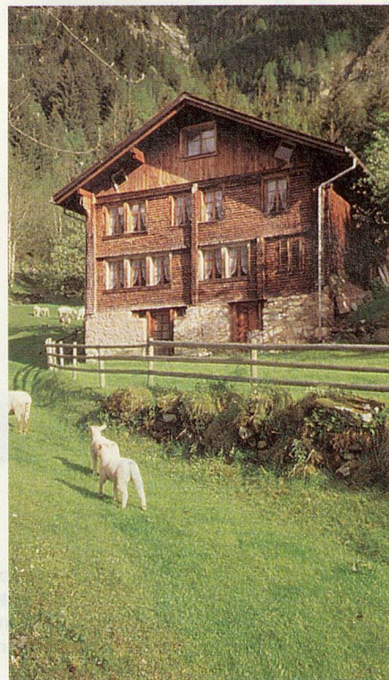
Das alte Wohnhaus auf 1000 m Höhe .
