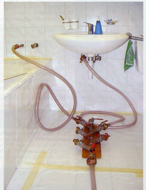
Nach der Rohr-Reinigung erfolgt die Innenbeschichtung der Wasserleitungen mit Epoxydharz.
