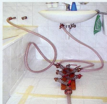
Nach der Rohr-Reinigung erfolgt die Innenbeschichtung der Wasserleitungen mit Epoxidharz.
