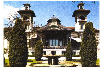
La Cinémathèque suisse à Lausanne
