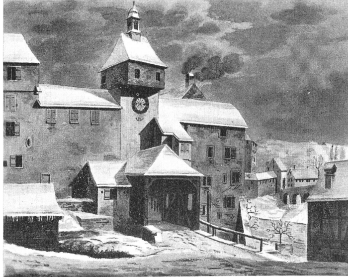
Das alte Obertor von außen
