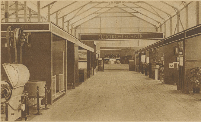
Blick in die Abteilung Elektro-Technik
