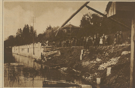
Die eingestürzte Seemauer bei Zug
