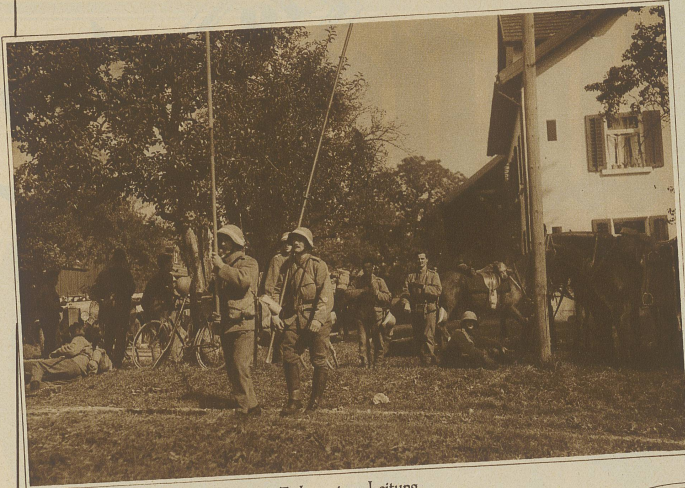
Telephonpatrouille beim Ziehen einer Leitung
