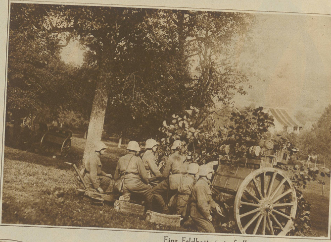
Eine Feldbatterie in Stellung
