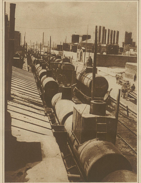
Blick auf eine große Petroleum-Destillationsanlage
