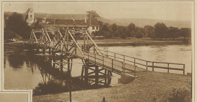
Die fertige Brücke über
