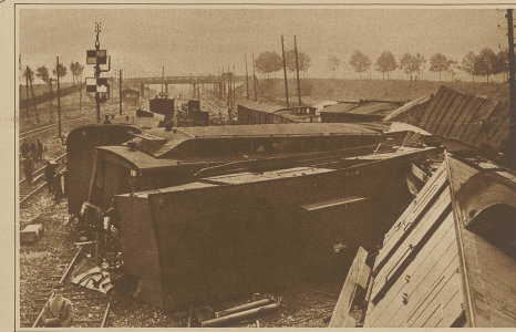
Blick auf das Trümmerfeld des bei Noisy le Sec wegen zu hoher Fahrgeschwindigkeit entgleisten Postzuges
