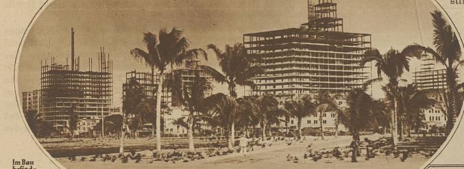
Im Bau befindliche Hotel in Miami. Man beachte die eigenartigen Gerichte, die es erlauben, den Bau nicht nur vom Fundament aus, sondern auch in oberen Stockwerken zu beginnen.
