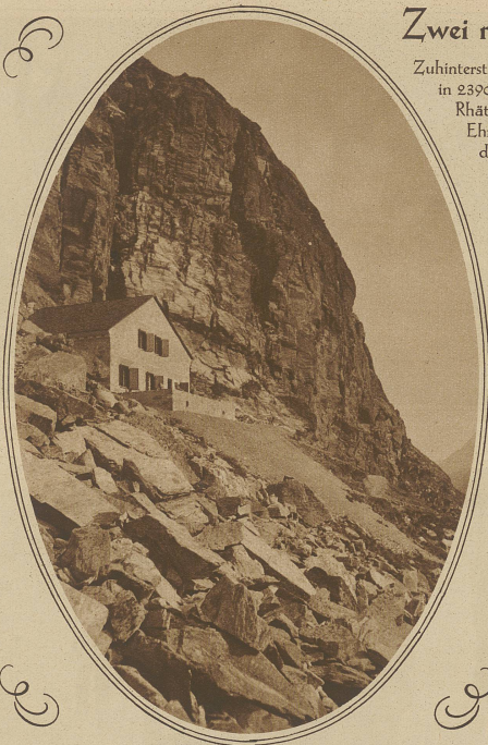
Ansicht der neuen Coaz-Hütte
