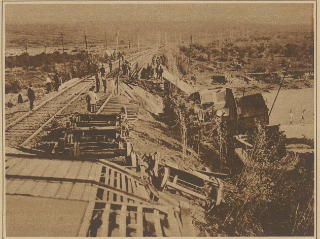
Ein schweres Eisenbahnunglück ereignete sich auf den chilenischen Staatsbahnen bei Querconque Bridge, wo durch Hochwasser der Bahndamm teilweise weggerissen wurde und der in der Nacht dahersausende Zug über die Böschung hinunter ins Wasser stürzte
