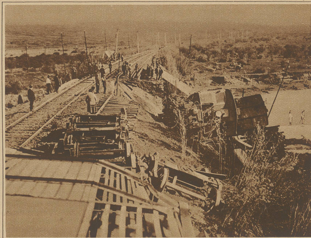
Ein schweres Eisenbahnunglück ereignete sich auf den chilenischen Staatsbahnen bei Querconque Bridge, wo durch Hochwasser der Bahndamm teilweise weggerissen wurde und der in der Nacht dahersausende Zug über die Böschung hinunter ins Wasser stürzte
