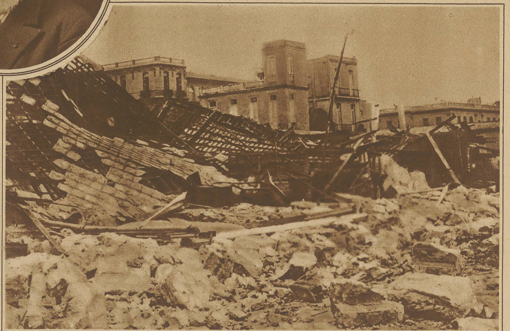
Ein Fabrikgebäude in Havanna, dessen mächtige Eisenkonstruktion durch den Sturm zum Einsturz gebracht wurde
