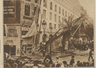
Schwere Unwetterschäden in Frankreich. Linsen Bild zeigt eine an einem Neubau auf dem großen Boulevard in Paris entstandene Schadenstelle, die von Paris auf die Straße gegenüber dem Hotel de la Paix übersehen wird.
