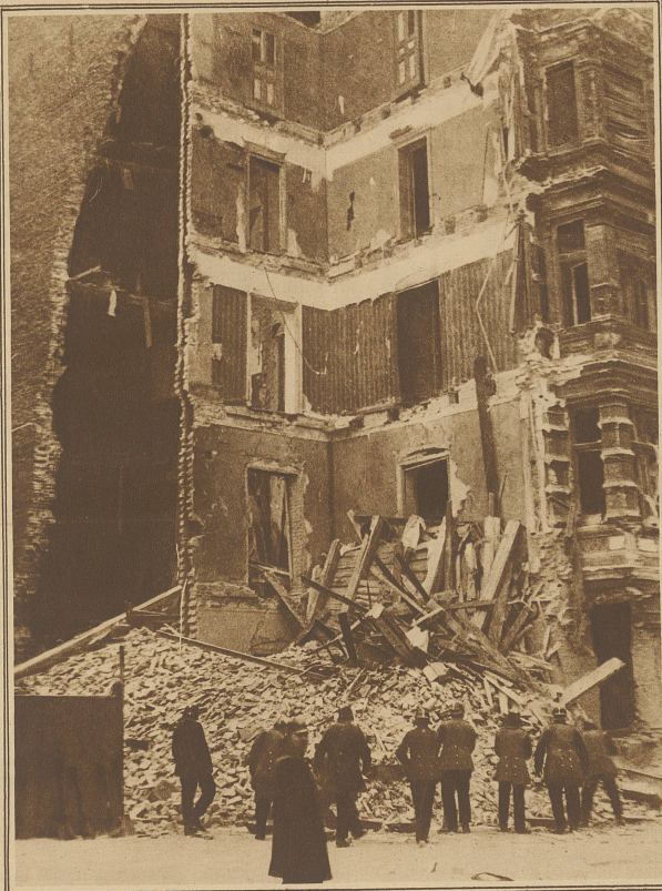
Die Trümmer des eingestürzten Hauses, unter welchen 9 Tote und 33 mehr oder weniger schwer Verletzte hervorgezogen wurden
