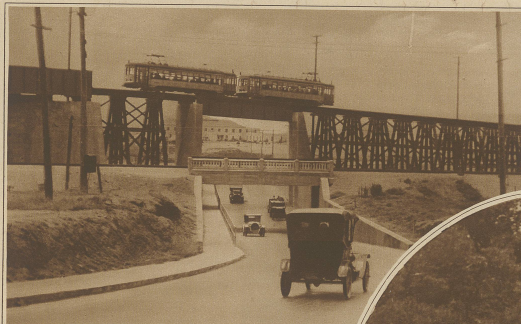
Eine fähige Verkehrskonstruktion, bei welcher Auto, Eisenbahn, Hochbahn und Fußgänger auf ihren sich kreuzenden Wegen unbehindert verkehren können
