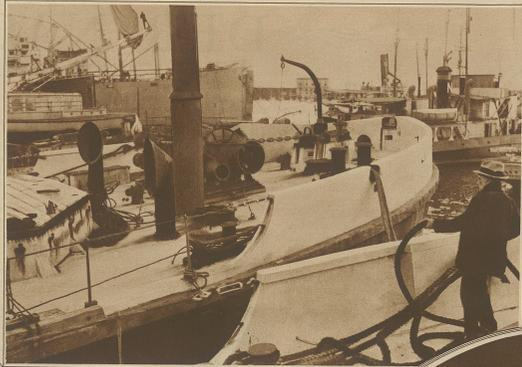
Zwei im Hafen liegende Lastschiffe aus Zement
