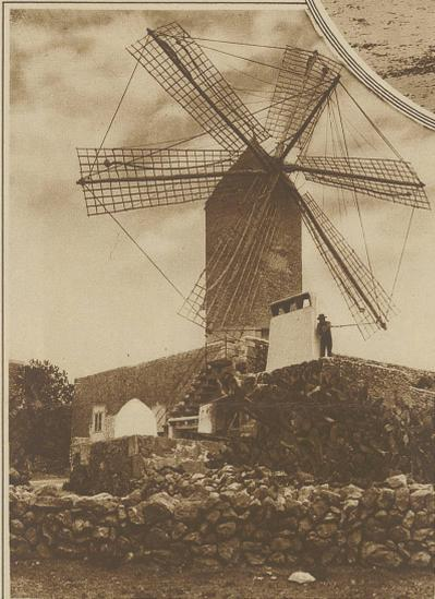
Typische Windmühle im Flachland der Insel. Die Mühle wird mit Segeln getrieben, die auf dem Bilde aufgerollt sind. Das Dach mit dem Räderwerk ist nach der Windrichtung verstellbar
