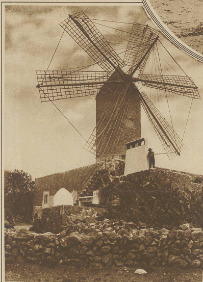
Typische Windmühle im Flachland der Insel. Die Mühle wird mit Segeln getrieben, die auf dem Bilde aufgerollt sind. Das Dach mit dem Räderwerk ist nach der Windrichtung verstellbar
